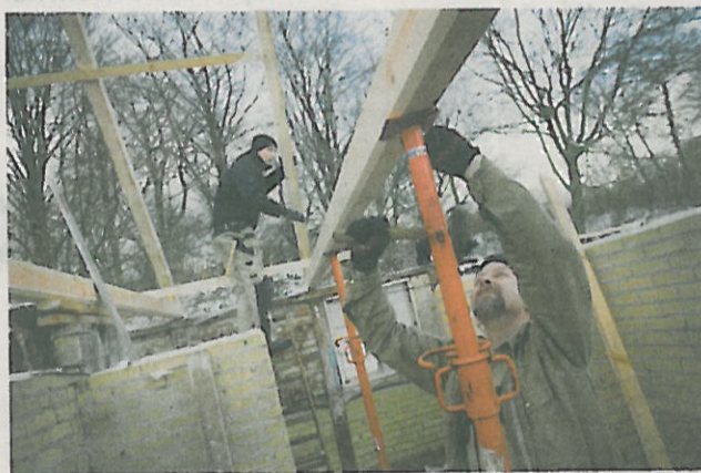
■ Tømrerfirmaet Henning Hansen fra Gelsted står for tømrerarbejdet under genopførelsen.
